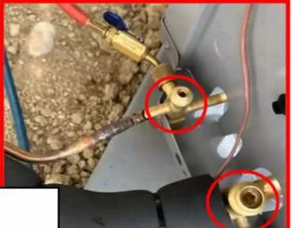
perador Service Valve: asegurar poner los tapones de bronce en ambas válvulas haciendo el roscado completo manualmente, y asegurar poner los tapones de hule en la tuberia sin rosca.
